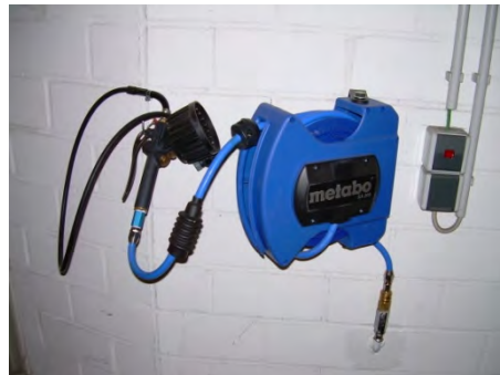
Druckluft-Station
