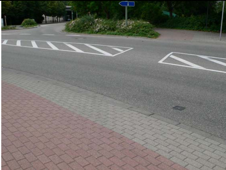
Radfahrerfurt in einer Kurve mit viel Lkw-Verkehr
